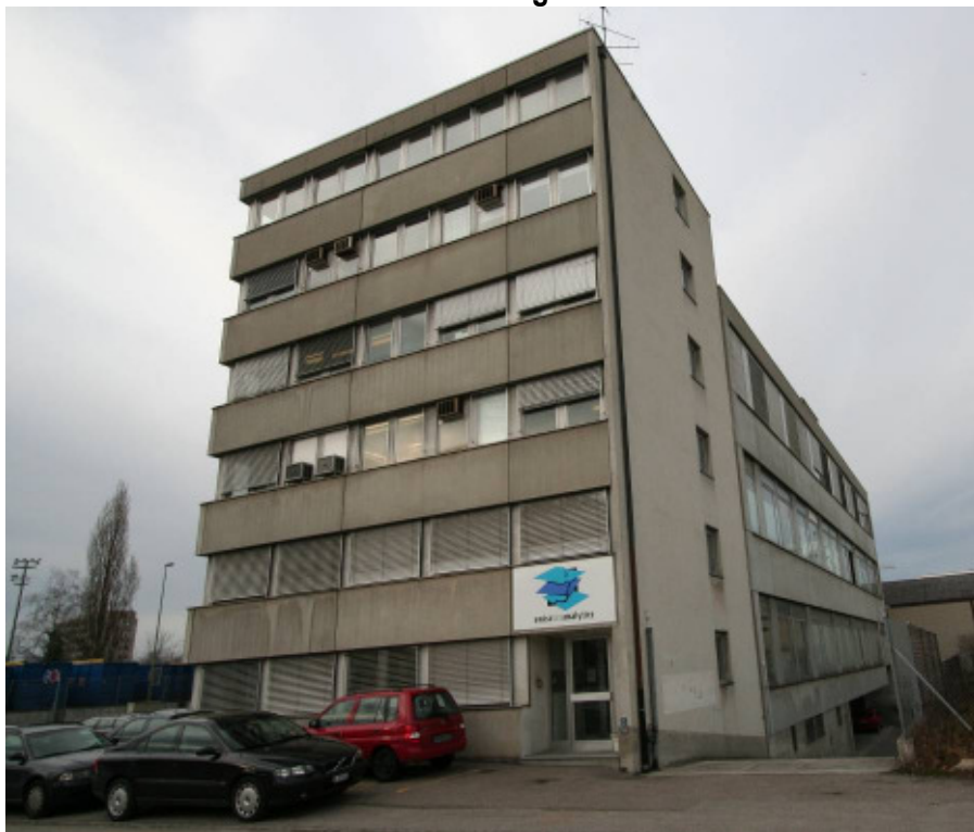
Sternenfeldstrasse 16, 4127 Birsfelden, Ansicht von Süden
